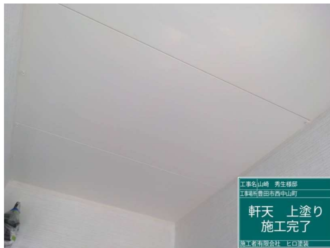
10 軒天 上塗り 施工完了
