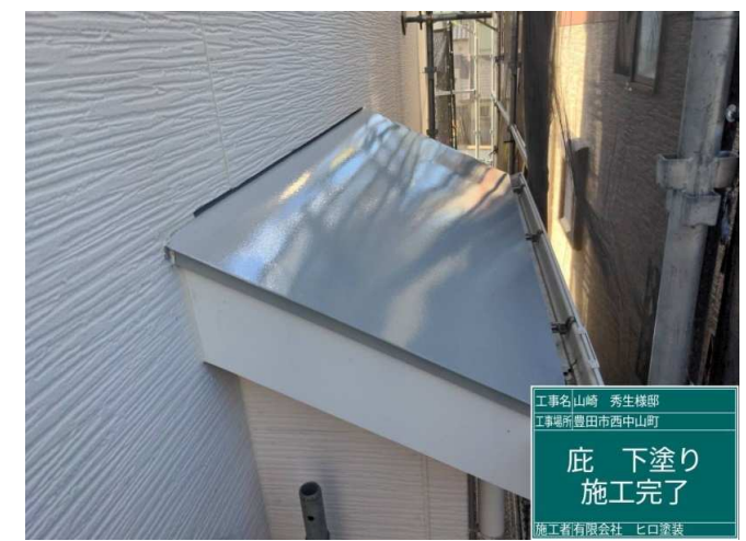
30 庇 下塗り 施工完了
