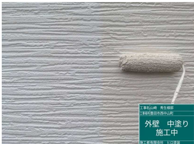
13 外壁 中塗り 施工中
