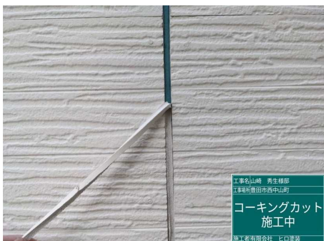
3 コーキングカット 施工中
