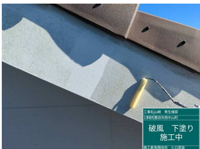
17 破風板 下塗り 施工中
