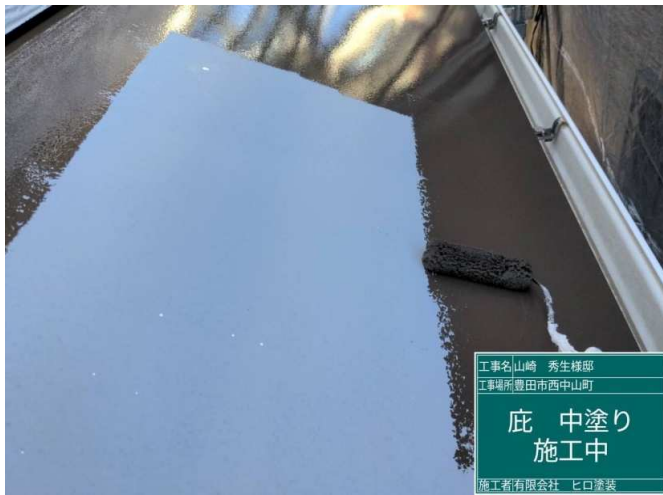
31 庇 中塗り 施工中
