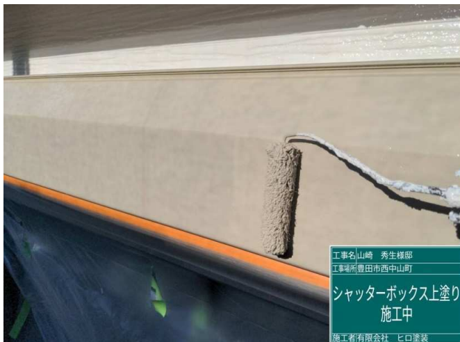
27 シャッターBOX 上塗り 施工中
