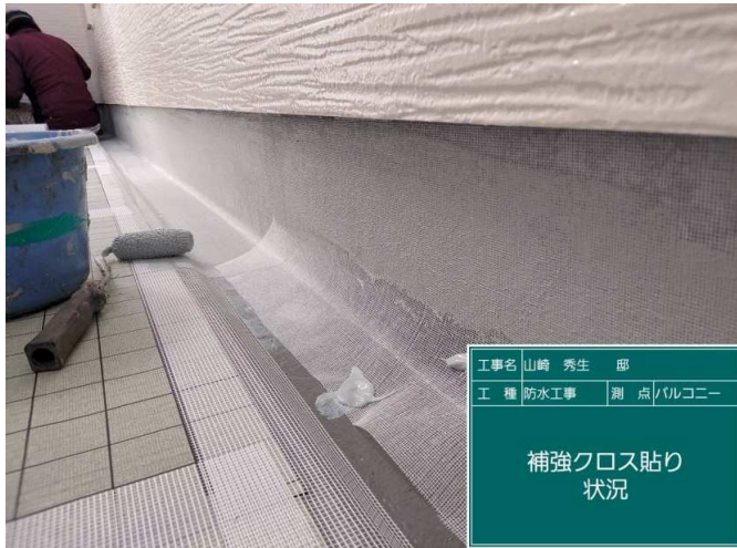
43 ベランダ 補強クロス貼り 施工中
