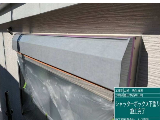
24 シャッター-BOX 下塗り 施工完了
