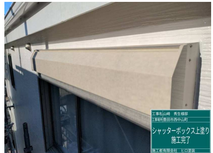
28 シャッターBOX 上塗り 施工完了
