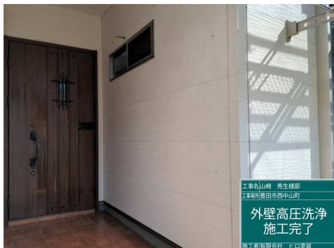
2 外壁高圧洗浄 施工完了
