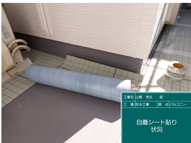
41 ベランダ 自着シート貼り 施工中
