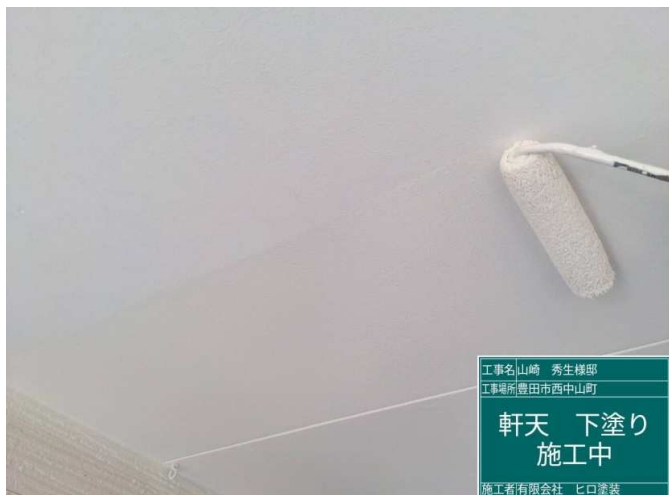
7 軒天 下塗り 施工中
