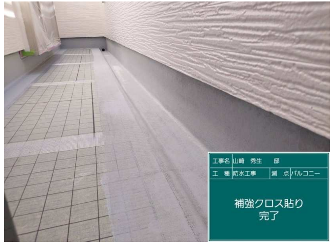
44 ベランダ 補強クロス貼り 施工完了
