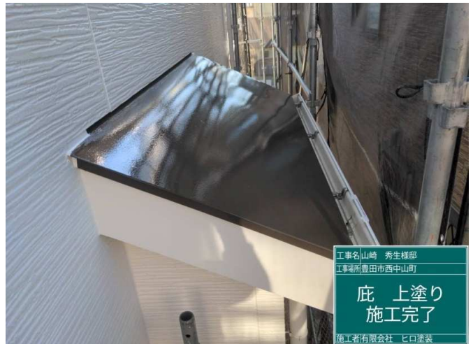
34 庇 上塗り 施工完了
