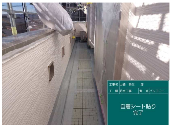
42 ベランダ 自着シート貼り 施工完了
