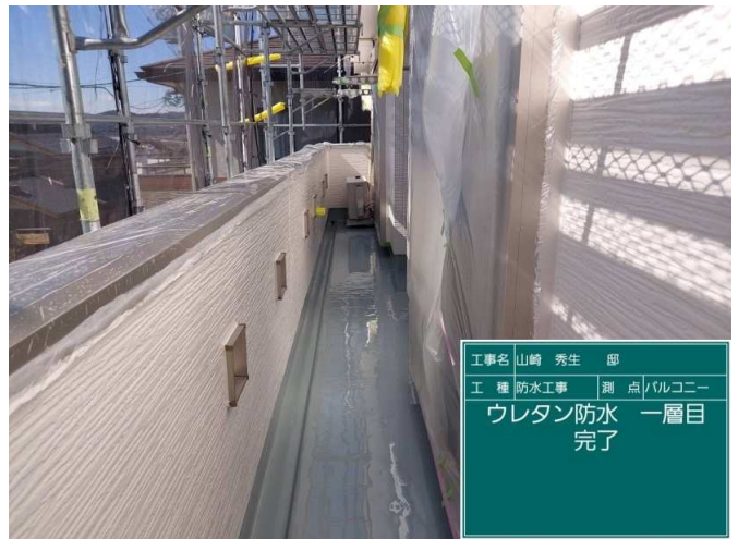
46 ベランダ ウレタン防水 1層目 施工完了
