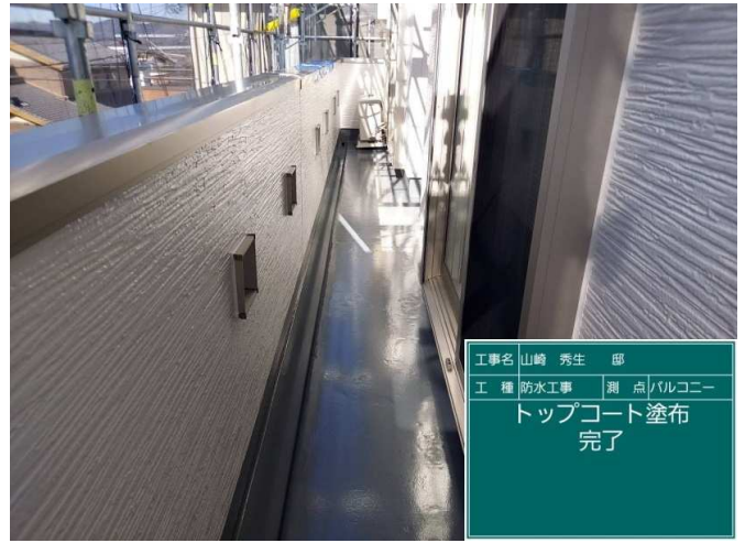
51 ベランダ トップコート 施工完了
