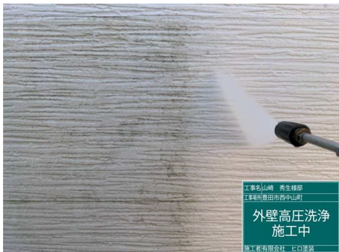
1 外壁高圧洗浄 施工中
