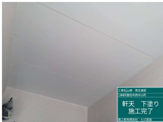
8 軒天 下塗り 施工完了
