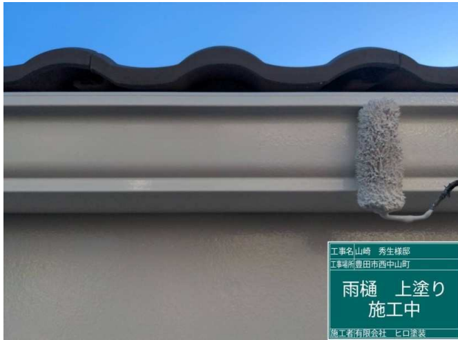
37 雨樋 上塗り 施工中
