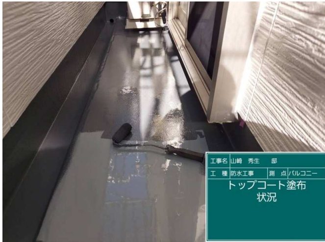
50 ベランダ トップコート 施工中
