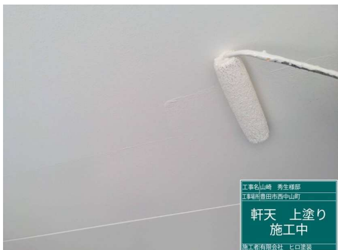
9 軒天 上塗り 施工中
