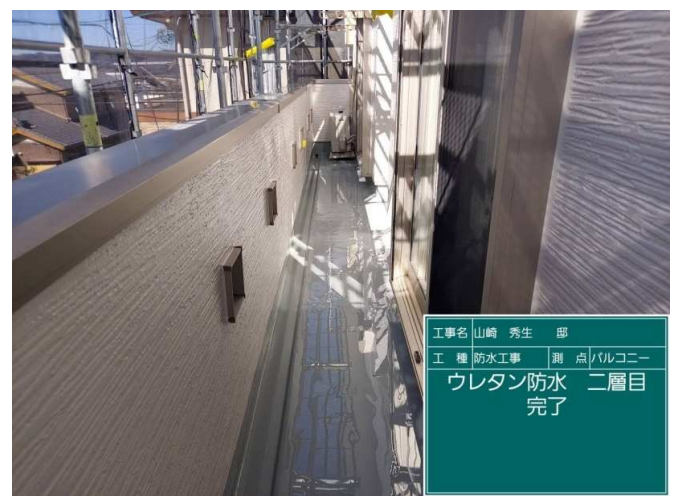
48 ベランダ ウレタン防水 2層目 施工完了
