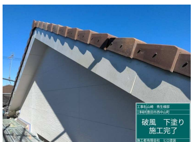
18 破風板 下塗り 施工完了
