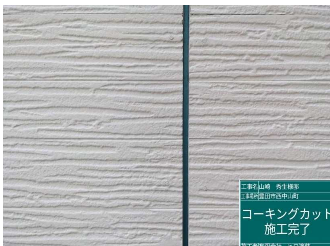
4 コーキングカット 施工完了
