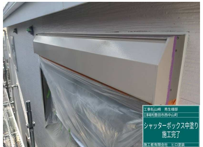
26 シャッターBOX 中塗り 施工完了
