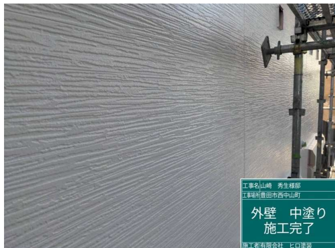
14 外壁 中塗り 施工完了
