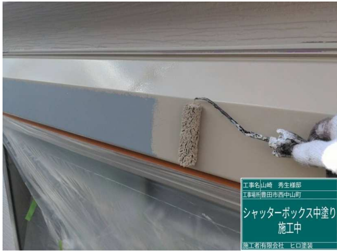
25 シャッターBOX 中塗り 施工中
