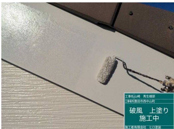
21 破風板 上塗り 施工中
