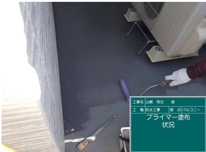
39 ベランダ プライマー 施工中
