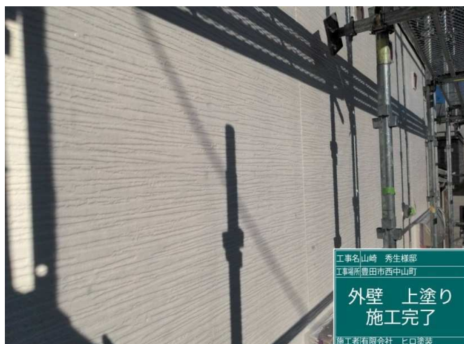
16 外壁 上塗り 施工完了
