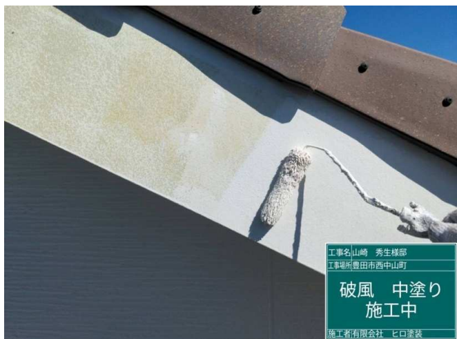
19 破風板 中塗り 施工中
