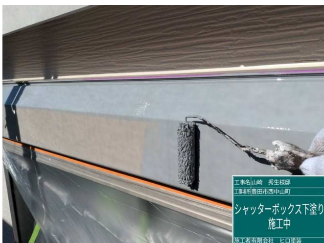
23 シャッター-BOX 下塗り 施工中
