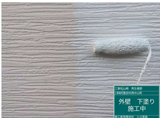
11 外壁 下塗り 施工中
