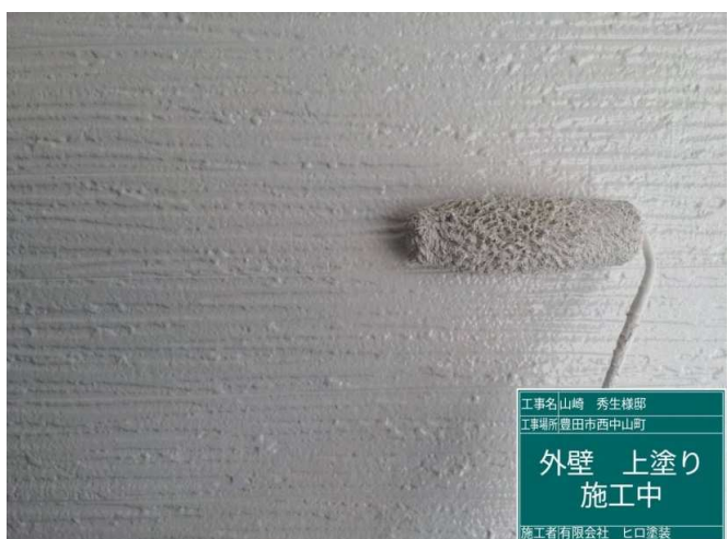
15 外壁 上塗り 施工中
