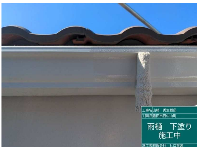
35 雨樋 下塗り 施工中
