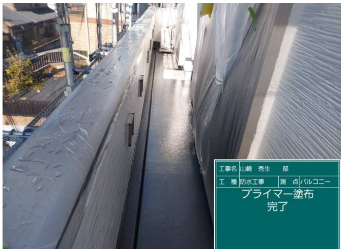
40 ベランダ プライマー 施工完了
