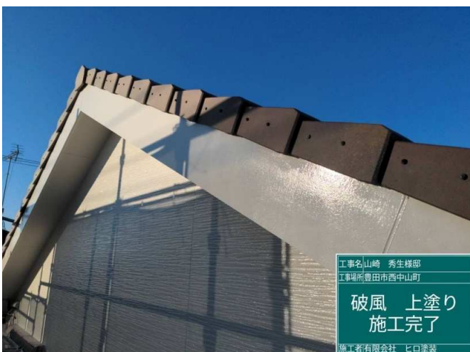
22 破風板 上塗り 施工中
