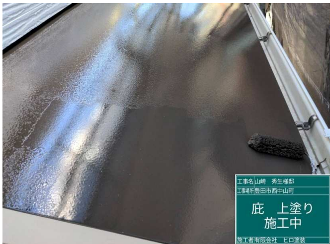
33 庇 上塗り 施工中
