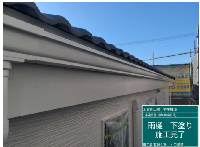
36 雨樋 下塗り 施工完了
