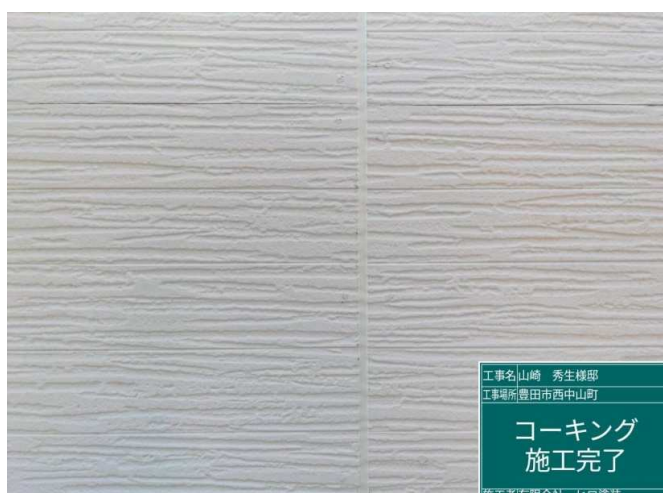
6 コーキング 施工完了
