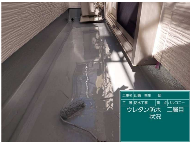
47 ベランダ ウレタン防水 2層目 施工中
